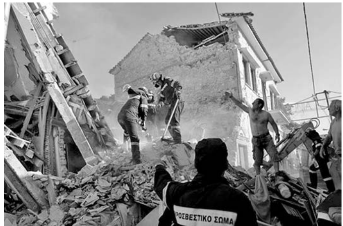
Разбор завалов после землетрясения в Греции 12 июня 2017 г.
