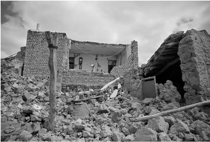
Последствия землетрясения в Иране 5 апреля 2017 г.
